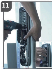
ยึดแผงด้านหลังและติดตั้งแบตเตอรี่
